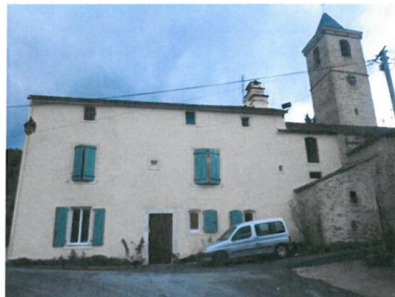
L'ensemble des façades du presbytère a été rénové. Pour la façade sud, après quelques travaux de rebouchage, c'est une belle peinture qui redonne belle allure au bâtiment. La façade ouest, trop dégradée a été rénovée en pierres apparentes. Les volets ont été repeints et une partie de la toiture, à l'arrière, rénovée.
