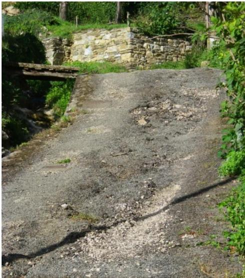
Le chemin du Pradel à la Caune devra être rénové dans son ensemble et l'eau qui arrive par le ravin canalisé. Des devis ont été demandés et le choix se portera sur de l'enrobé ou du béton. Une buse et un radier de béton placés à l'intersection qui a vu le débordement permettront de sécuriser ces lieux. La commune a été placée en état de catastrophe naturelle, aussi nous espérons une subvention de l'Etat sous forme de DGE (dotation globale d'équipement) pour l'année 2014.
